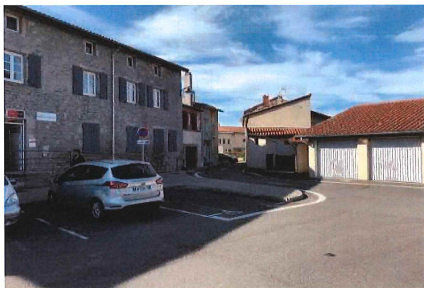
DP 8: Photographie de loin
