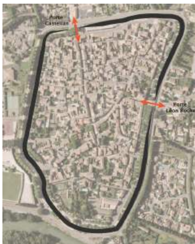
La digue et les portes d'accès au centre-ancien, réalisation : EVEN CONSEIL
