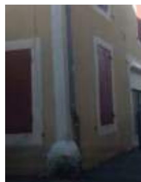
Renfort au niveau de l'angle du bâtiment
