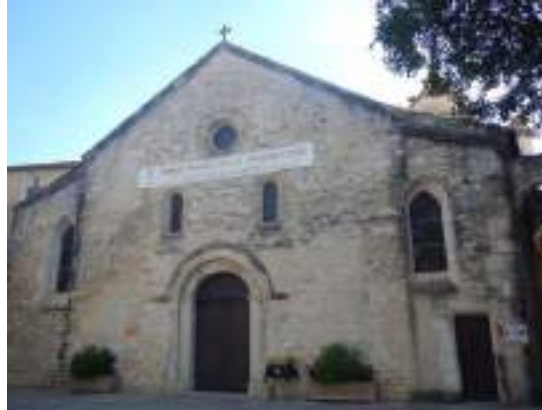
La façade principale de l'église
