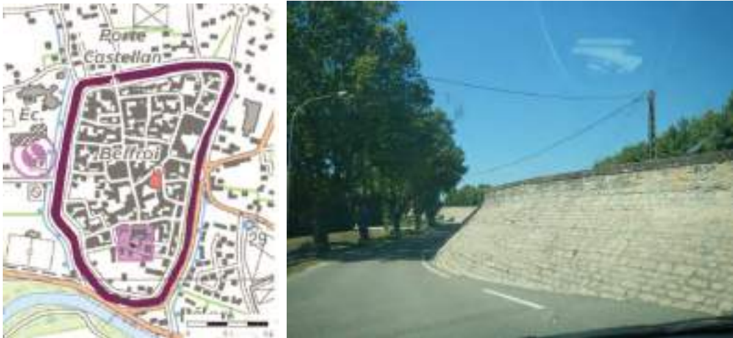
Le périmètre de l'immeuble inscrit, source : atlas des patrimoines ; la digue
