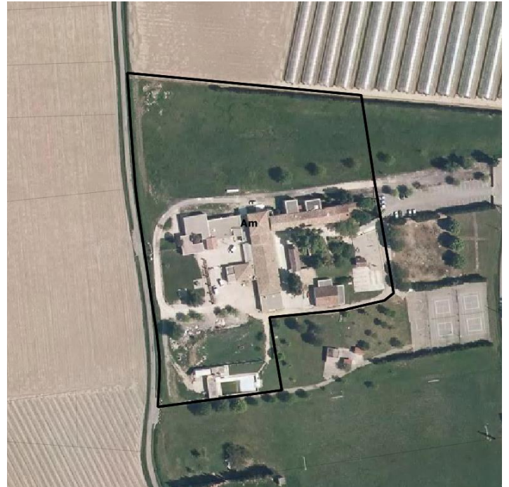
Photographie aérienne du STECAL Am
