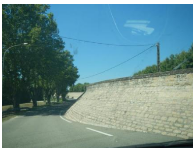
La digue de la ceinture de la ville
